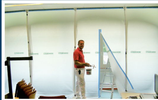
TRAVAUX DE PEINTURE Bâtiment d'école
