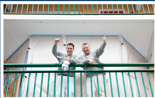
PEINTURES A L'EXTERIEUR Bâtiment locatif/PPE
