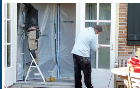
RENOVATION DE PORTES ET CADRES Appartement
