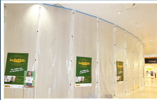
CONSTRUCTION D'UN MAGASIN Centre commercial
