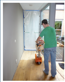
PONÇAGE DE SOL Appartement
