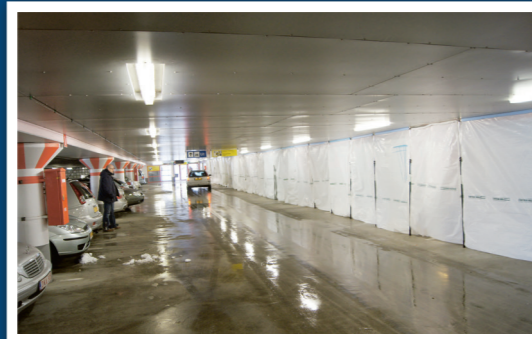
TRAVAUX DE PEINTURE Garage souterrain
