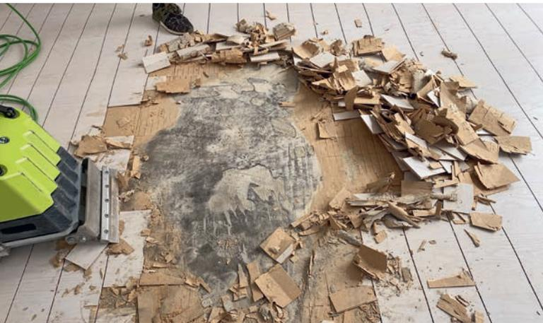
**Vollflächig verklebte HDF- sowie MDF-Parkettflächen lassen sich kaum noch mit einer Stripmaschine entfernen.**
